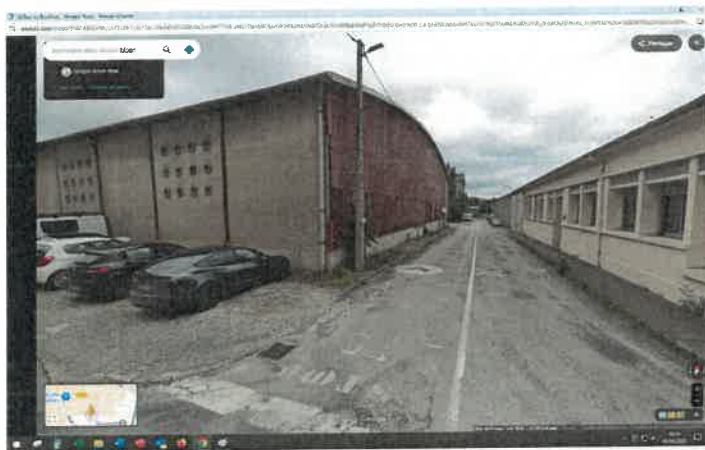
1 – Angle rue Bradford / Rue du Conditionnement
